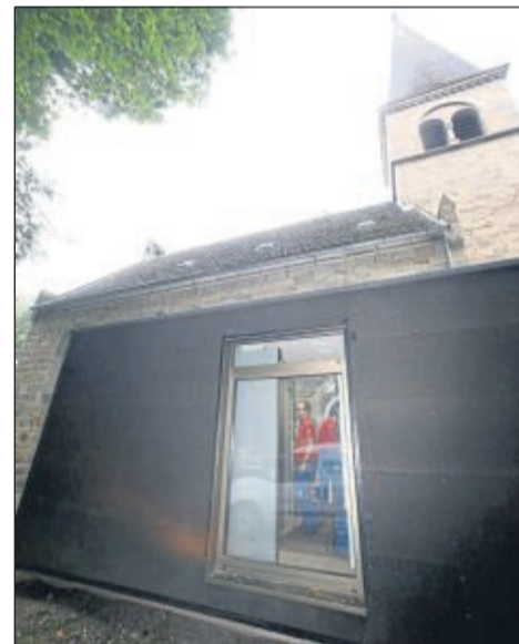
Behelfsfarbe: Der containerartige Anbau hat noch nicht seine endgültige Farbe und Oberfläche. Die Bleche werden heller.
