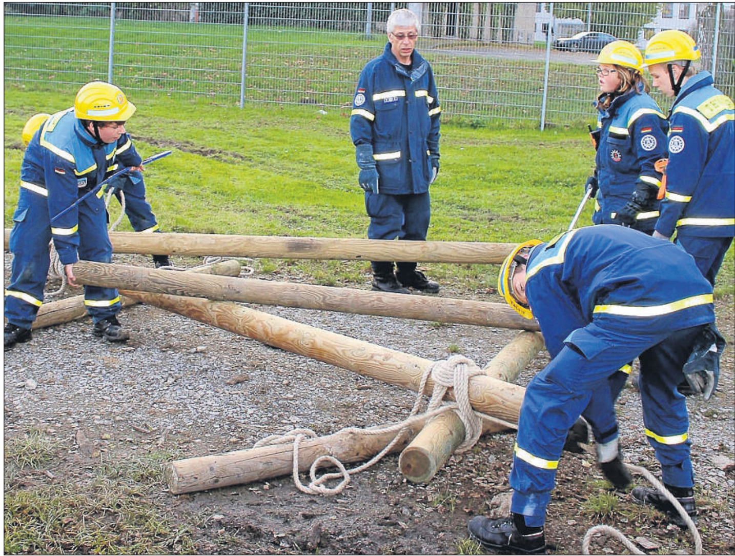
Chinasteg des Technischen Hilfswerk Hofgeismar: Unter Leitung von Dieter Schröder bauen die Jugendlichen einen Übergang für Fußgänger und Radfahrer. Fotos: Hoffmann
