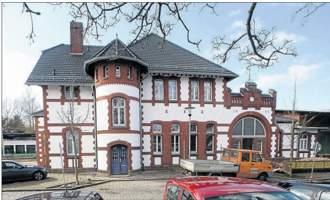
Ab 2016 will hier auch die VHS einziehen: der sanierte Bildungsbahnhof in Hümme.
