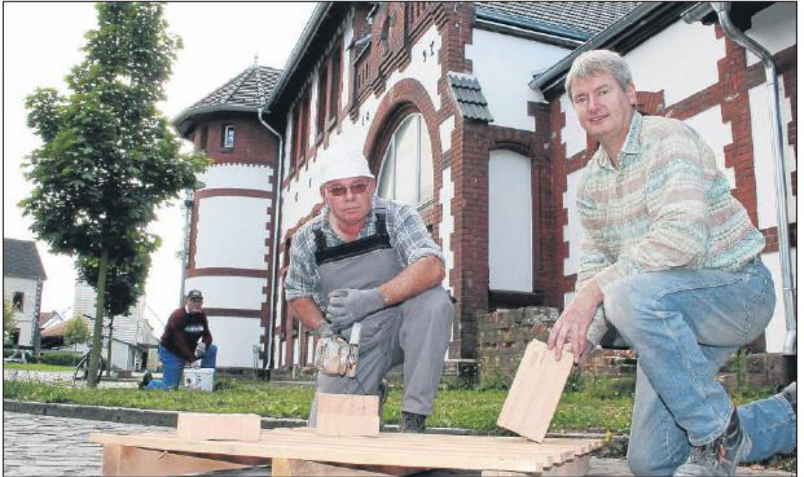
Die Fassade des Bahnhofs sieht gut aus: Rudi Forejt (links) und Peter Nissen machen hier Steine passend, die für eine Brandschutzmauer im Keller benötigt werden. Die Fassade ist fast fertiggestellt – bis auf einige Fenster und die Verglasung des Eingangsbereichs, muss hier nichts mehr erneuert werden.
