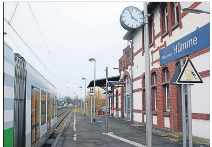
Gemeinsames Projekt: Verein, Stadt und Kirchengemeinde stemmen den Umbau des Bahnhofs.
