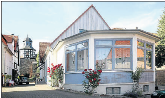
Nicht mehr genutzt: Das evangelische Gemeindehaus in Hümme (vorne rechts) wird aus Kostengründen geschlossen, ebenso wie das angrenzende städtische Gemeinschaftshaus (dahinter). Sie werden voraussichtlich nach dem Umzug verkauft. Foto: Thiele
