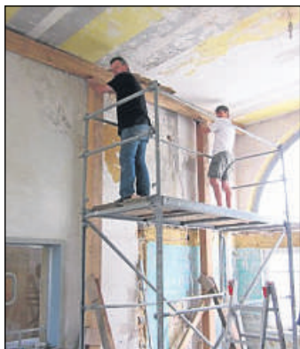
Abstützarbeiten im Bahnhof Hümme.
